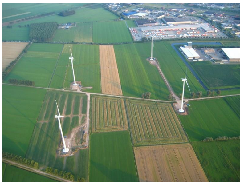
Figuur 13 Overzicht Windpark Duiven, 4 windturbines van 2 MWe, totaal 8 MWe
